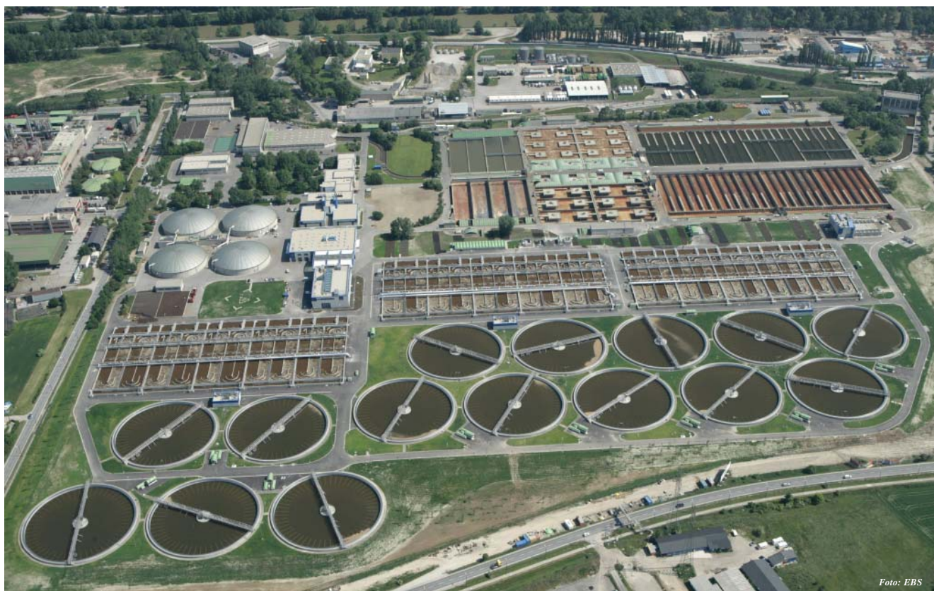
Die Großkläranlage der Stadt Wien in Simmering.
